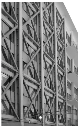
Рис. 5. Наружная антисейсмическая стальная ферма спального корпуса Университета Беркли 18
