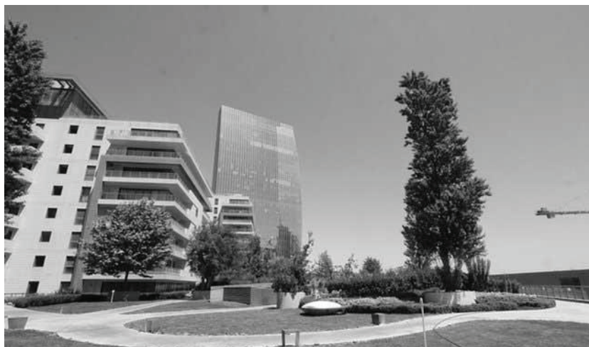
Рис. 2. Пример зелёной крыши
