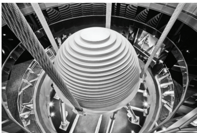
Рис. 1. Инерционный демпфер в конструкции здания
