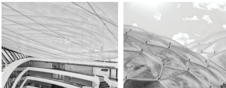
Рис. 8. Подушки из материала ETFE в качестве ограждающих конструкций 9
