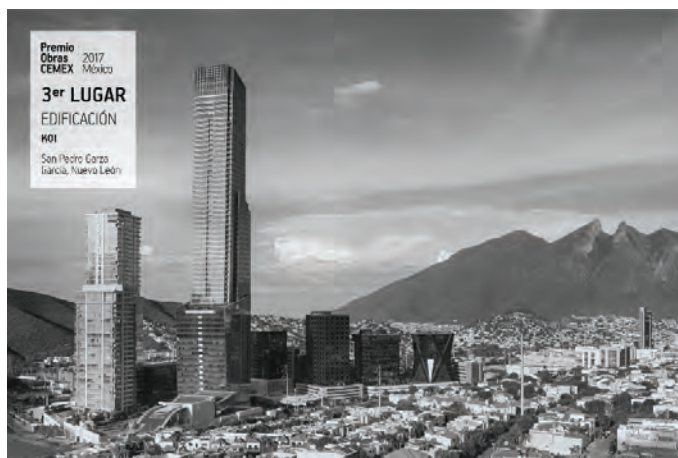
Рис. 4. Торре Кои в городской застройке 5
