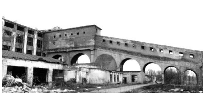
Рис. 2. Эстакада взгона главного корпуса. Фото П.М. Расторгуева
