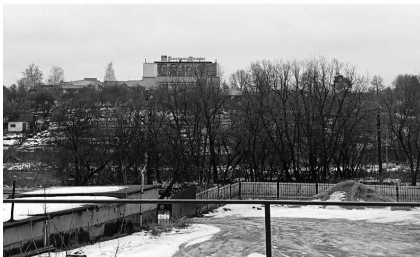
Рис. 5. Вид на исторический корпус с противоположной стороны р. Талка. Фото А.В. Снитко
