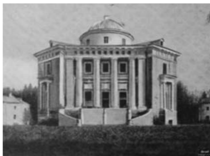
Рис. 7. Историческое фото главного здания 10
