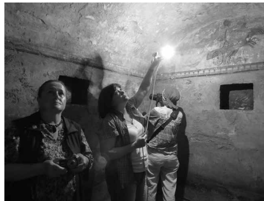
Рис. 2. Обследование стеновой живописи реставраторами Эрмитажа, ГОСНИИР, ВКИКМЗ. Фото Н. Л. Кучеревской, 2018 г.
