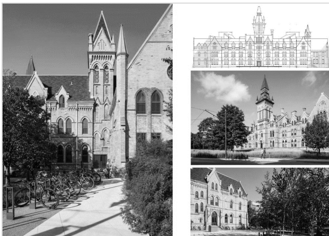
Рис. 10. Южный фасад и фотофиксации колледжа KNOX для факультета архитектуры университета Торонто (современный вид)
