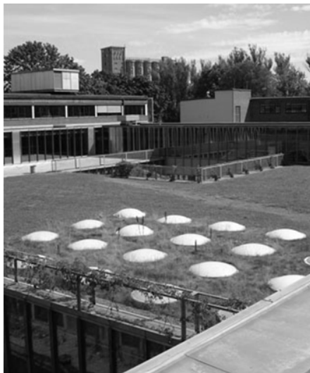
Рис. 11. Зенитные фонари на озелененной кровле обеспечивают освещение зрительного зала (источник: https://architecturerevived.com/oslo-school-of-architecture-and-design-aho/ )
