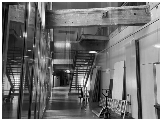
Рис. 13. Сохранившиеся бетонные конструкции в интерьере школы. Фото Е.Г. Трибельской
