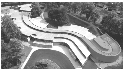
Рис. 2. Школа «Hazelwood» в Глазго, Шотландия. Северная часть здания для основных учебных помещений
