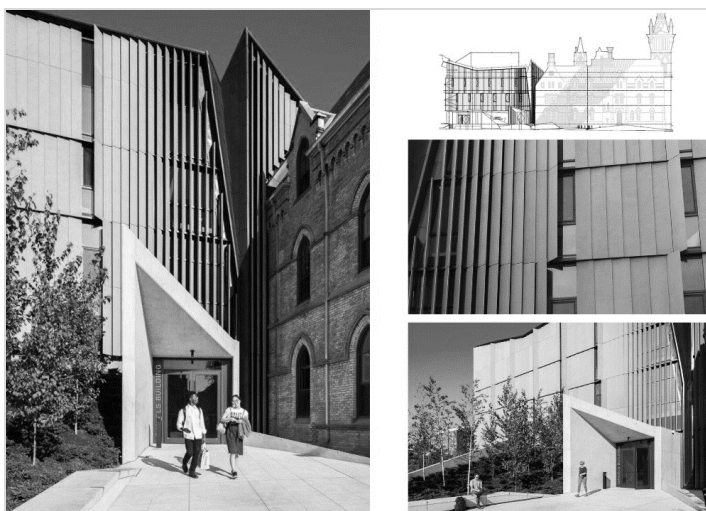
Рис. 11. Западный фасад и фотофиксации KNOX для факультета архитектуры университета Торонто (современный вид)
