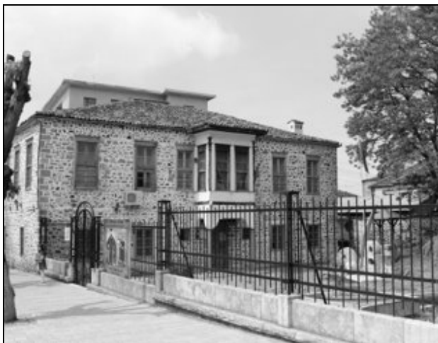
Рис. 1. Историческое здание первой национальной школы
