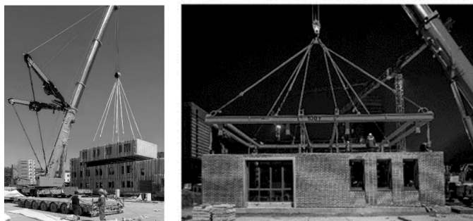
Рис. 10. Монтаж жилого здания из модулей
