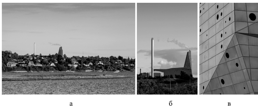
Рис. 13. ТЭЦ «Линия сжигания»: а – панорама города Роскилле; б – вид на здание электростанции с севера; в – фрагмент облицовки фасада [5]
