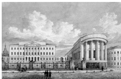
Рис. 5. Новое здание Московского университета на Моховой улице [6]
