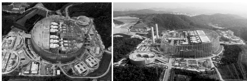
Рис. 23. Тепловая электростанция «Круг энергии» в процессе строительства [9]
