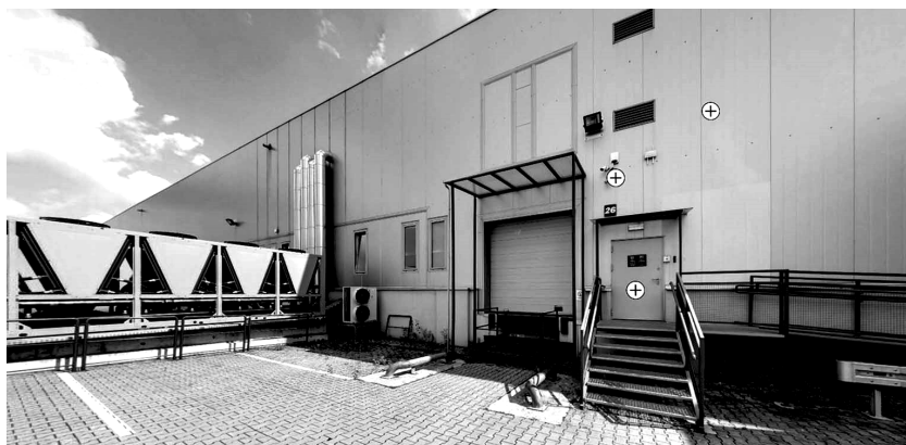
Рис. 2. Сервисная зона у ЦОД WAR2 в Варшаве, Польша
