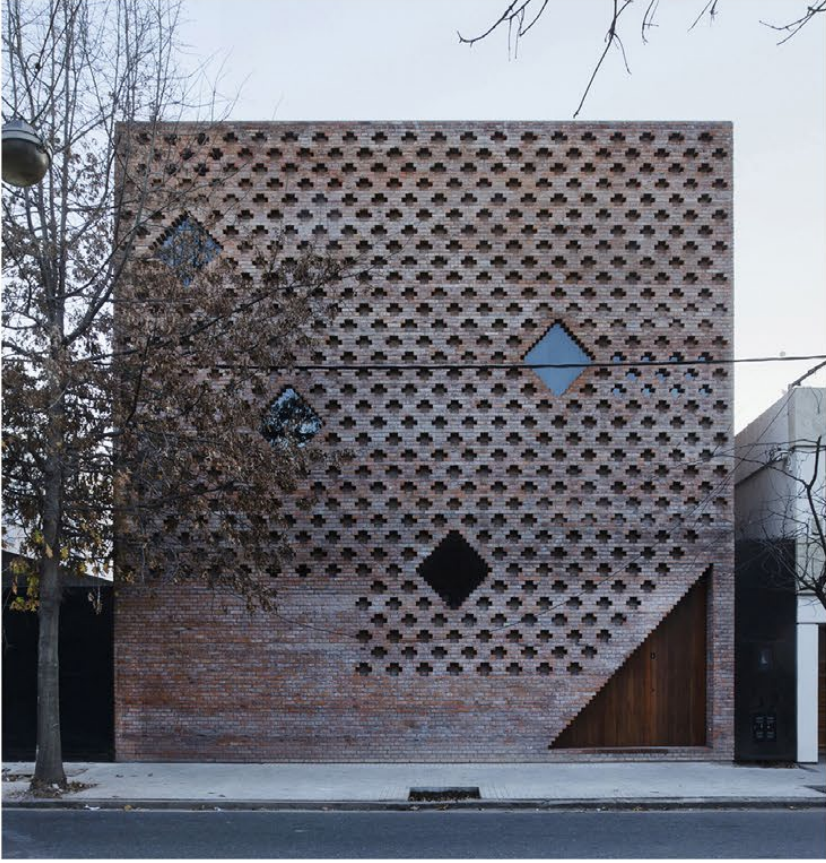
ФАСАД С УЛИЦЫ
